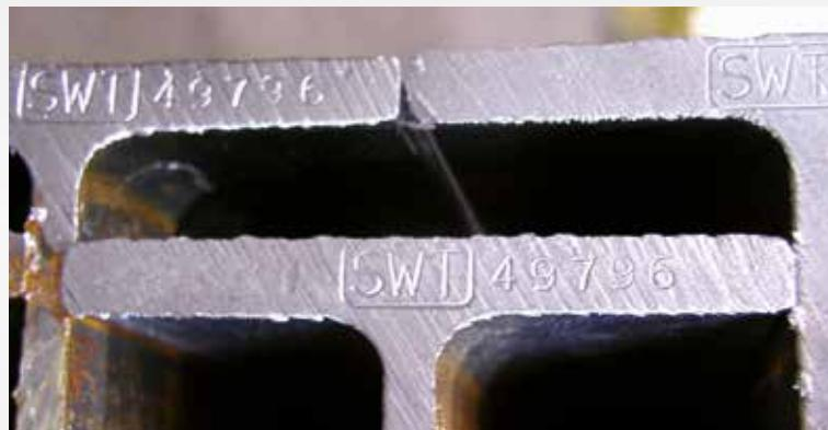
Beispiel Stahlstempelung | Example die stamping | Exemple de poinçonnage
